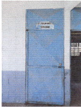
Foto 1: Mantenimiento a estructura, lijado, cepillado, aplicación de pintura a 10 puertas de las aulas y 6 puertas de los sanitarios.
