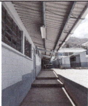
Foto 7: Sustrucción de alubrado eléctrico en 7 aulas y los correctores, se cambiarán las lámparas por focos led.
